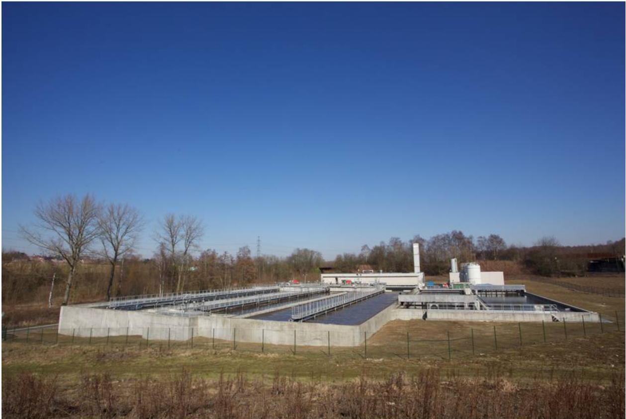
Station d'épuration de ViESVILLE (IGRETEC)
