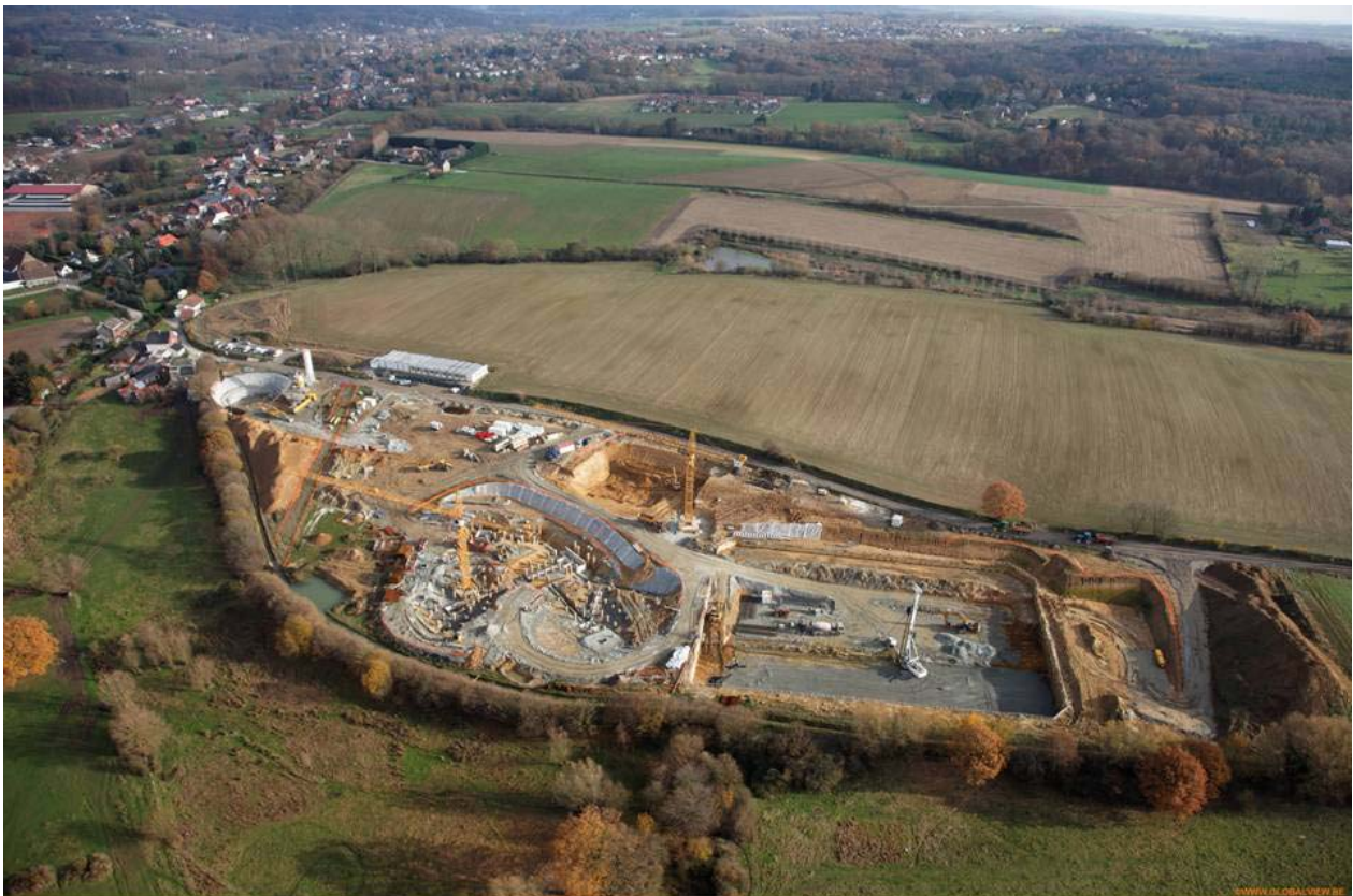
Chantier de la station d'épuration de la Vallée du Hain (IBW)
