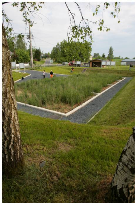
Station d'épuration de XAIMONT- LEGLISE (AIVE)
