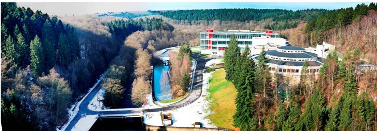
Station de traitement d'EUPEN (SWDE)
